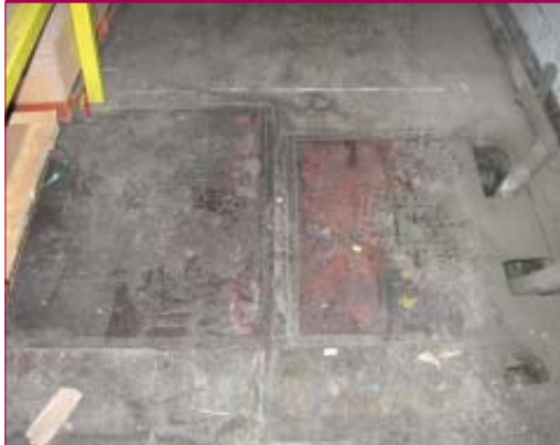
Bassin de rétention
